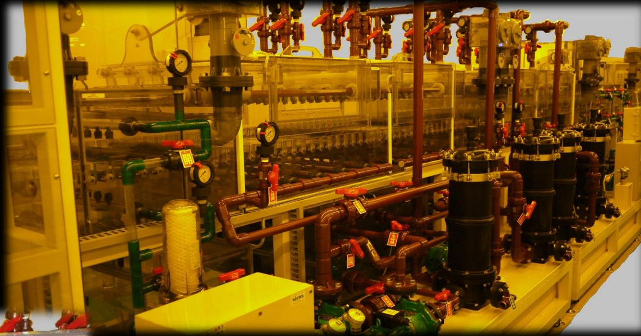
DFR剥離 自動濾過 DFR Strip Automatic Filtration
